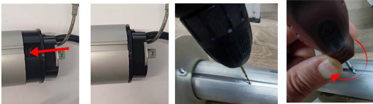
15) Установите заглушку для трубы 63мм LIFT (803012-0000) с противоположной стороны и просверлите отверстие диаметром 3,2 мм в ранее отмеченном месте трубы. Зафиксируйте заглушку саморезами 3,5x13 DIN7981C (310469-0000)
