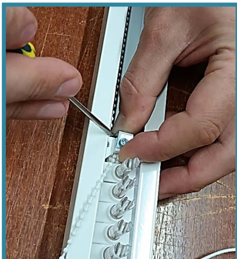
Установить зажим в фиксатор
