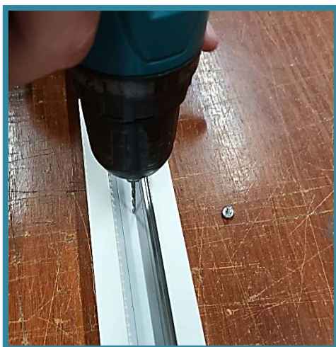
В середине карниза просверлить Отверстие сверлом 2 мм
